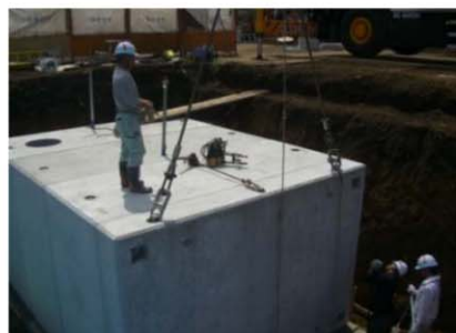
公園地下に防火水槽設置
