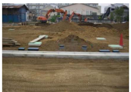
宅地造成(保留地)
