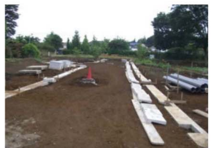
道路整備(埋設 上下水、ガス)
